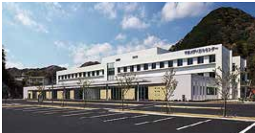
下田メディカルセンター
